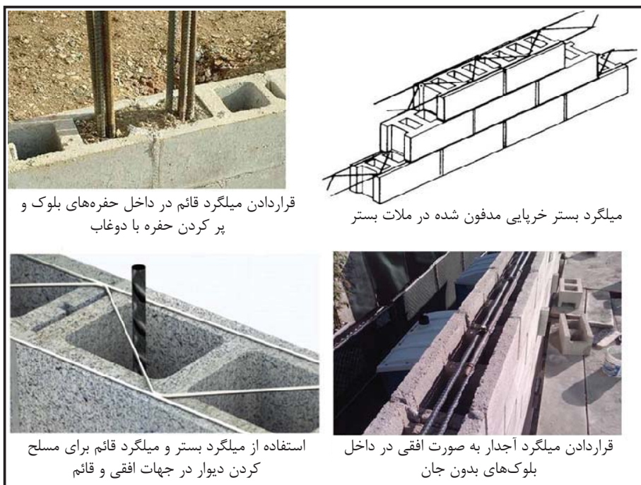
شکل پ. ۴-۵- دیوارهای بنایی مسلح
